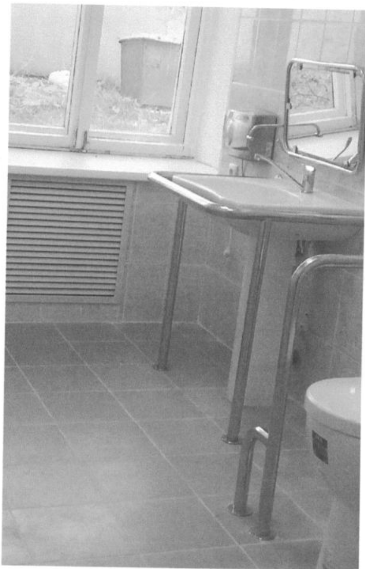
Фото № 17 санузел - мойка с поручнем и специальным смесителем, поворотное зеркало, сушилка для рук, ул. Октябрьская, дом 12.
