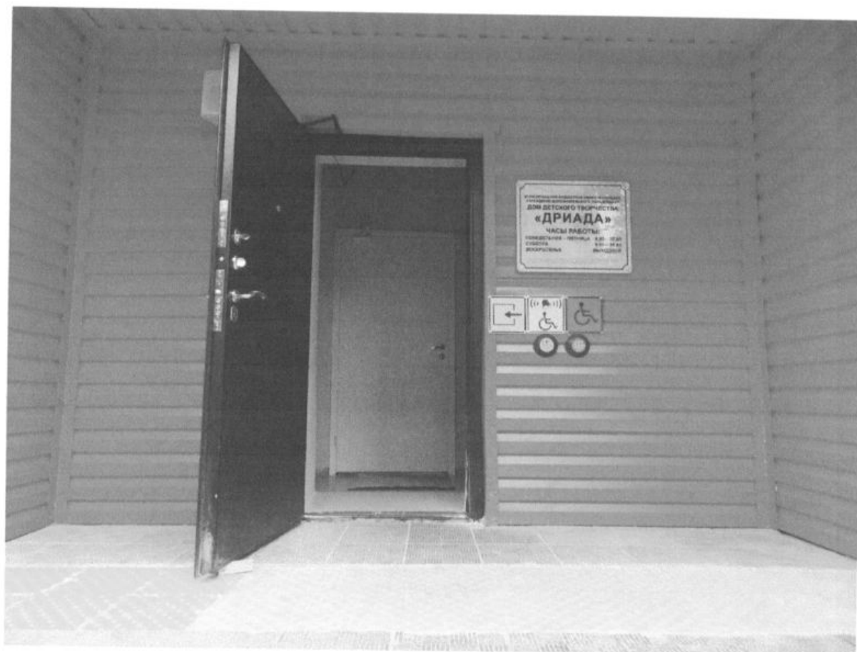
Фото № 9 площадка перед центральным входом в здание № 1: кнопка вызова персонала, звуковой маяк для слабовидящих и незрячих, кнопка включения звуковой информации, тактильные указатели и вывеска, расширенная дверная группа, ул. Октябрьская, дом 12.
