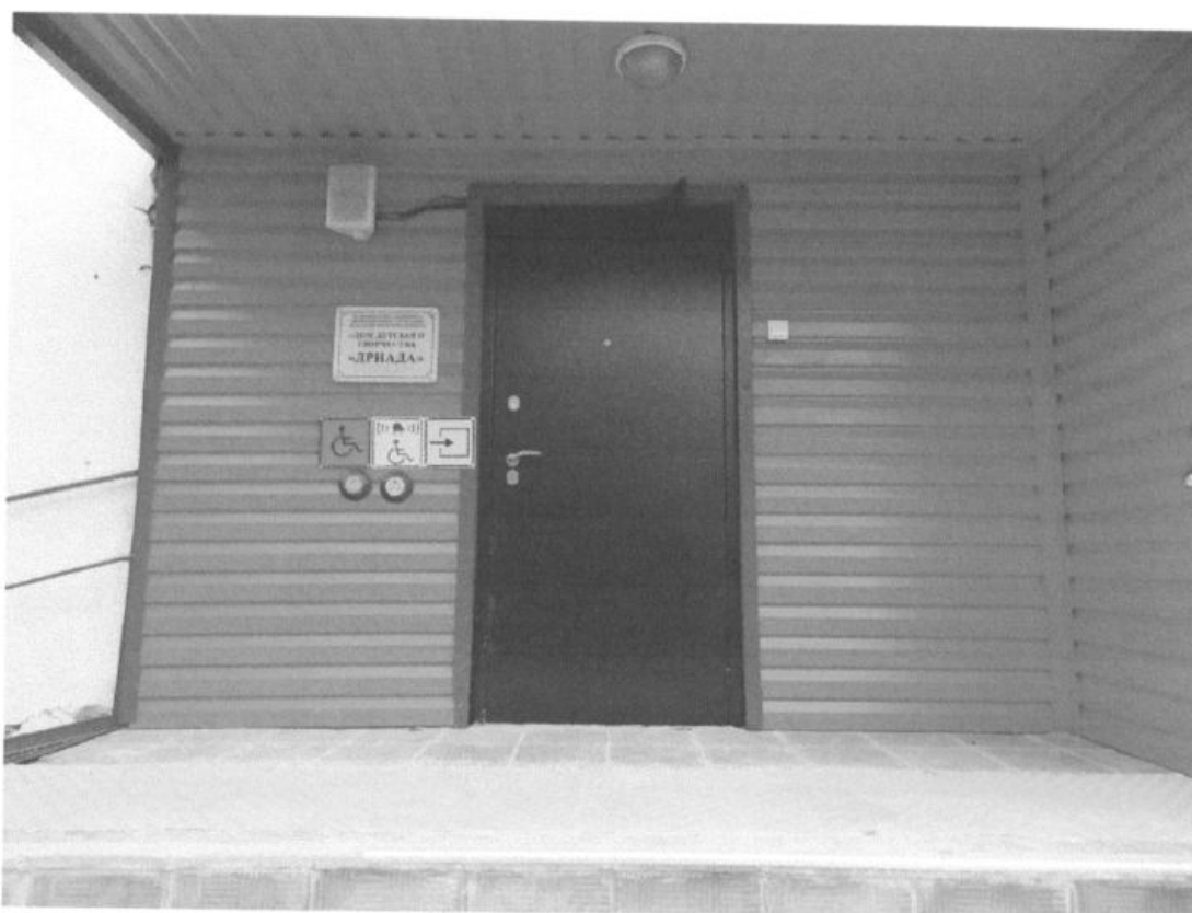
Фото № 4 площадка перед входом в здание: кнопка вызова персонала, звуковой маяк для слабовидящих и незрячих, кнопка включения звуковой информации, тактильные указатели и вывеска (запасный вход) ул. Октябрьская, дом 12.
