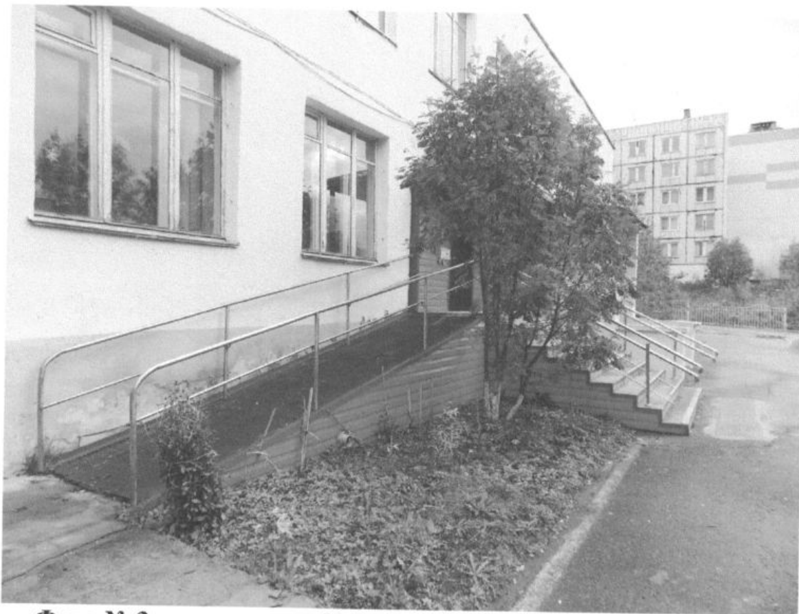
Фото № 3 вход в здание № 2, пандус ул. Октябрьская, дом 12.
