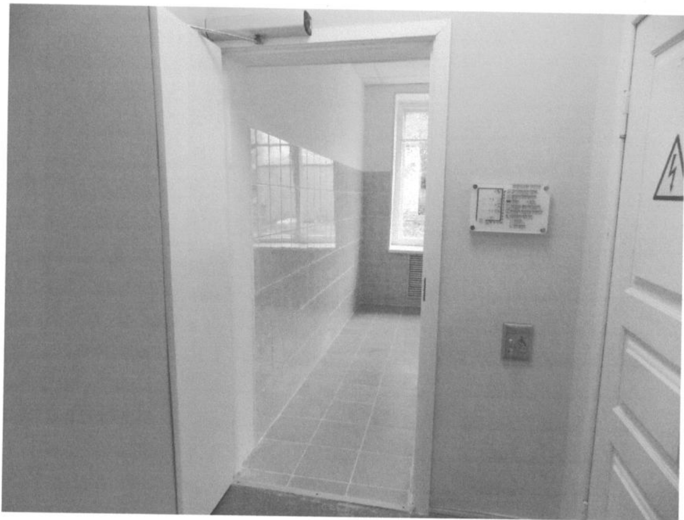
Фото № 12 вход в санузел ул. Октябрьская, дом 12.
