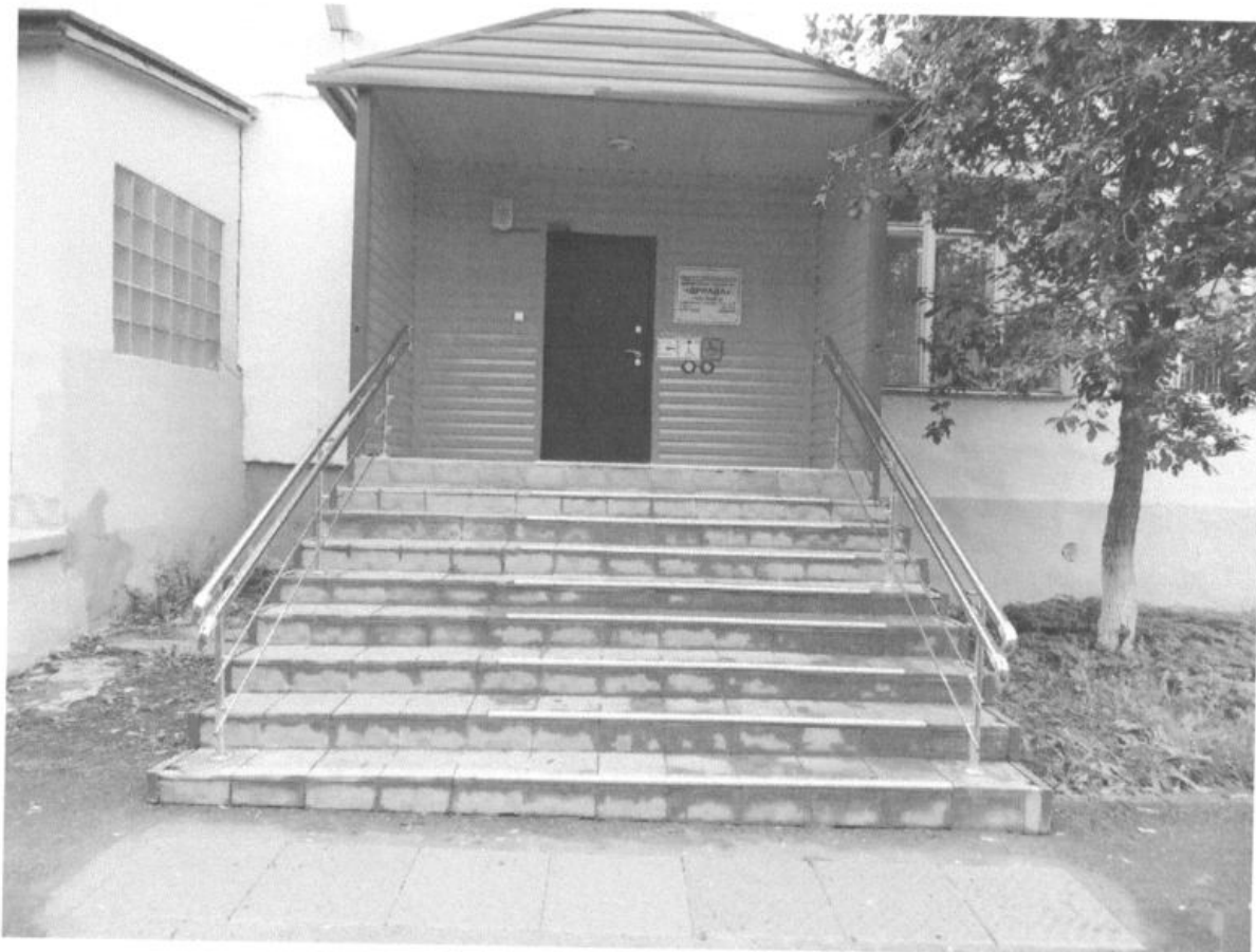
Фото № 8 центральный вход в здание № 1 ул. Октябрьская, дом 12.
