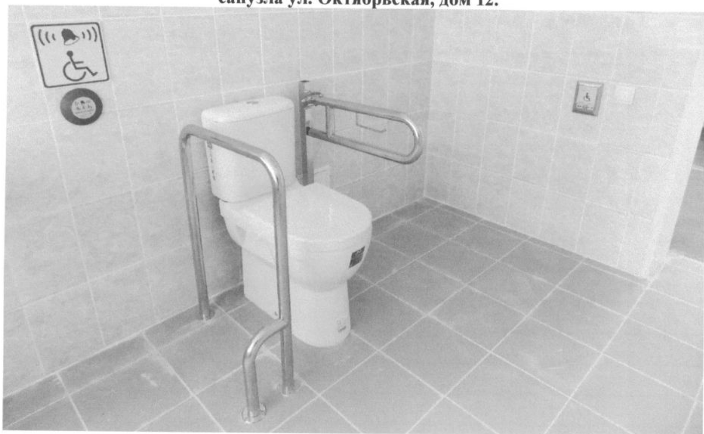
Фото № 15 санузел – пульт управления автоматической системы запираения двери с информационным звуковым оповещением, унитаз с поручнями, кнопка вызова персонала с тактильным информационным указателем,
